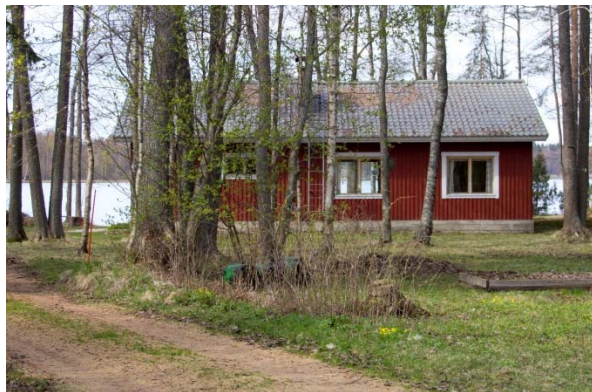
Vuonna 1988 rakennettu asuinrakennus, pohjoisin rakennuksista.
